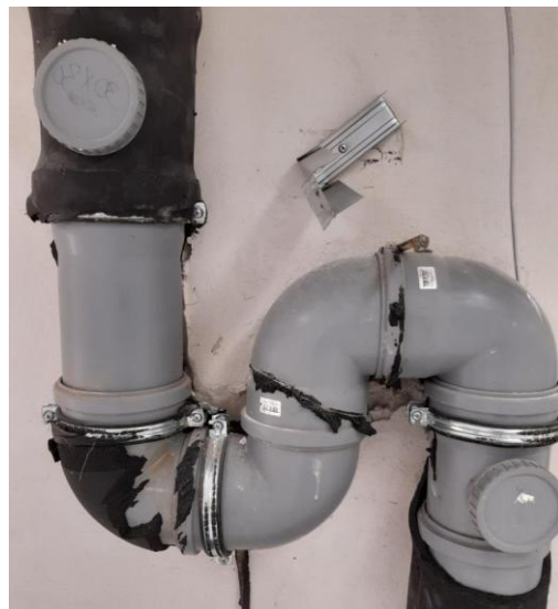
Obr.: 6.4 Protizápachové sifony rozvodů kanalizace / stoupaček střešních svodů
