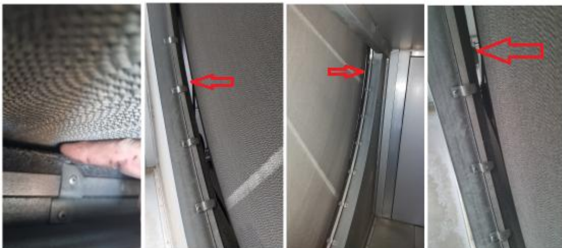
Obr. 10 Příklady nadlimitních netěsností mezi kolem a těsnicí lištou
